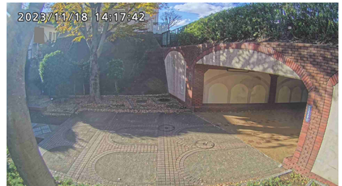
四季の径トンネル トンネル方向
