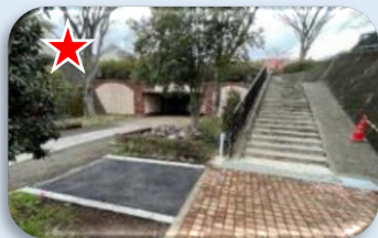
RCA/泉土木協業・歩道新設
